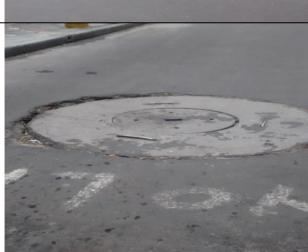
CIV SEGMENTO 17000335. 17000311, CARRERA 3 ENTRE CALLES SEXTA Y SÉPTIMA. Se evidencia afectación carpeta en asfáltica alrededor del cargue instalado. siendo este el primero ubicado de sur a norte sobre la carrera igualmente se evidencia asentamiento diferencial del mismo con inclinación significativa por posible fallo en paredes del pozo levantadas en mampostería.
